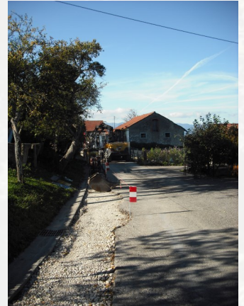
Un bouclage du réseau d'eau a été réalisé par la rue de la Fruitière
