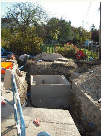
D'importants travaux d'eau pluviale sont réalisés au châte
