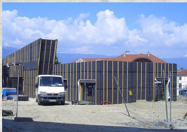
Le multi-accueil de Valleiry en construction
