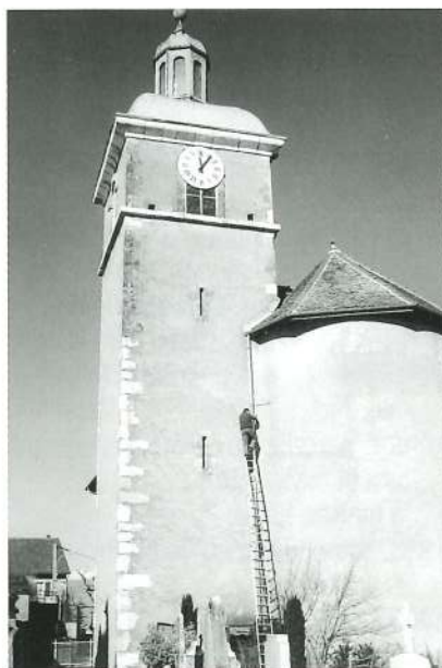
Travaux réalisés à l'église, dans le cadre de la mise en conformité du chauffage alimenté en gaz par l'extérieur
