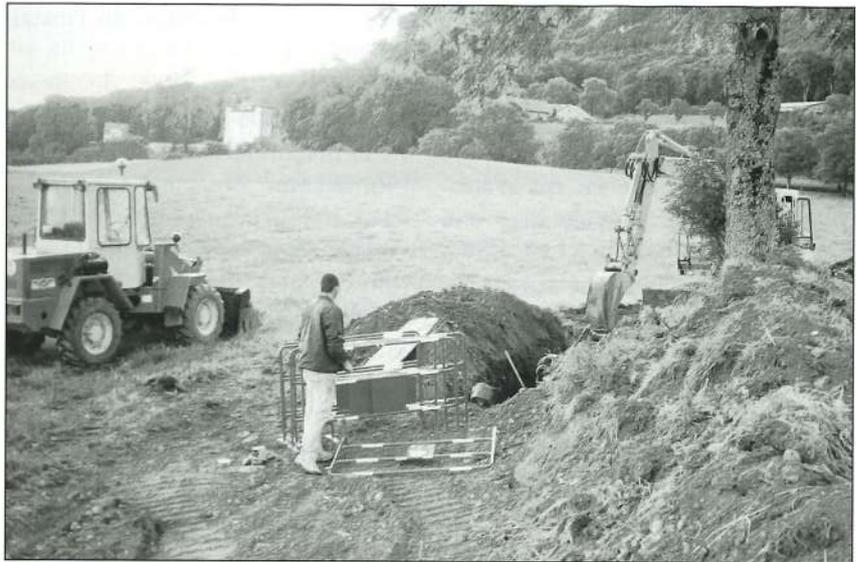
technique dit «chambre des vannes», lui-même préfabriqué, est adossé au réservoir.
