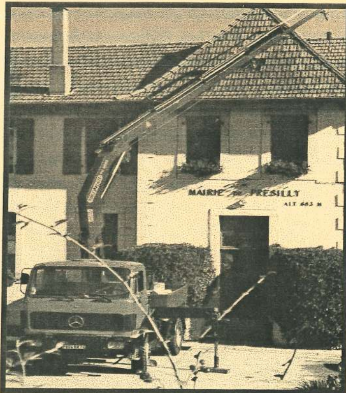
TRAVAUX DE LA TOITURE EN OCTOBRE 2001
