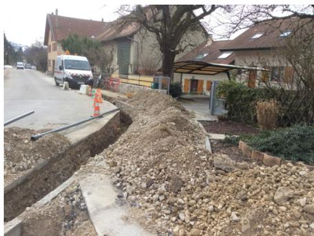
La société de télécommunication ORANGE a mandaté l'entreprise EIFFAGE Télécom pour la pose de 6 tubes diamètre 60mm dans une tranchée de 80cm de profondeur et de 342m de longueur. Ces fourreaux serviront au passage de câbles reliant la chambre de connexion (située face à la pizzeria) au relais télécom (route du Petit-Châble). Ces lignes sont destinées à renforcer le réseau téléphonique du lotissement du Plat, route de Bel Air.
